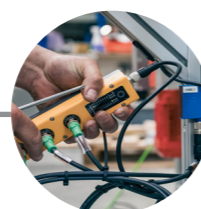
Installation vor Ort
